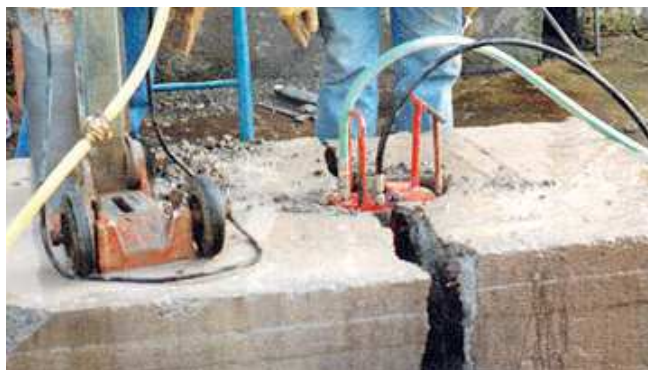
Spalten mit Presszylindern
