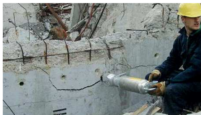
Spalten durch Pressen – Keilprinzip
